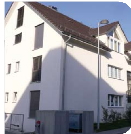
MFH, Falkenstrasse / Wettsteinstrasse, Rüti
